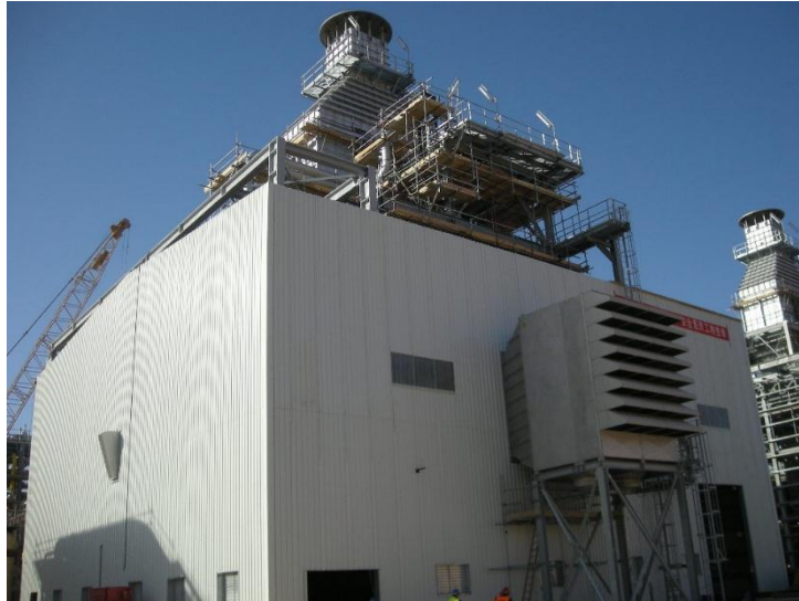
Fig. 5-2 Turbine PGT25 dans le site TEG
