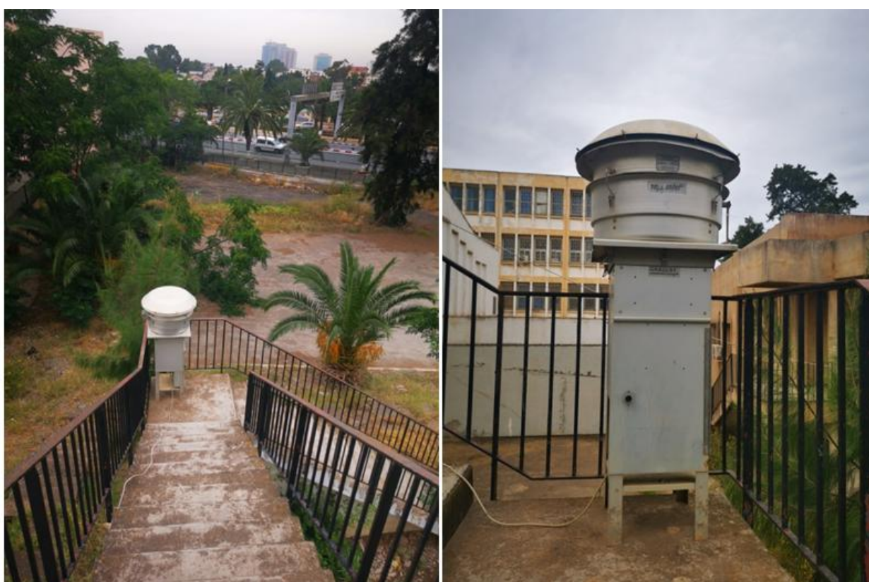
Figure IV.2 : Photos de l'appareille utilisé.
