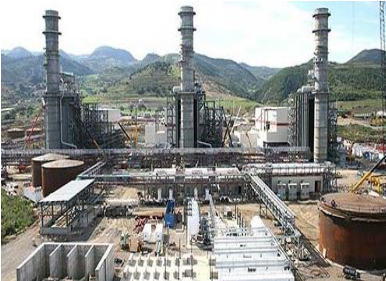
Figure 5: La centrale électrique de Hadjret Ennous (GE, 2009)
