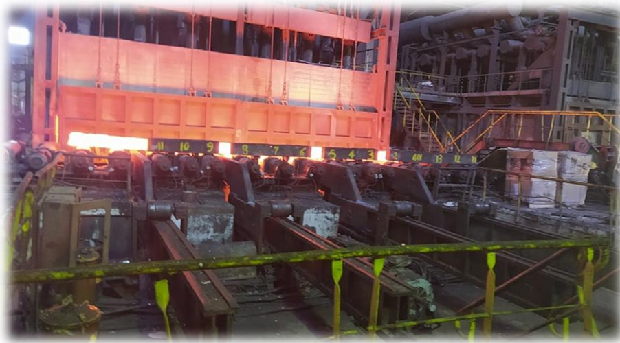
Figure I.2.9 : Photo d'un four poussant
