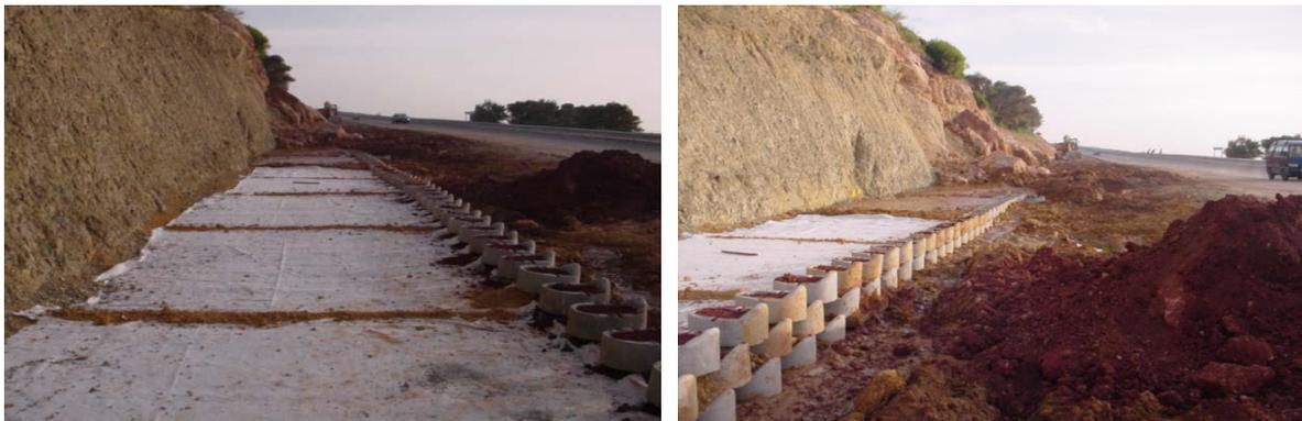
Figure 8.4 : Première couche de remblai et première nappe de renforcement
