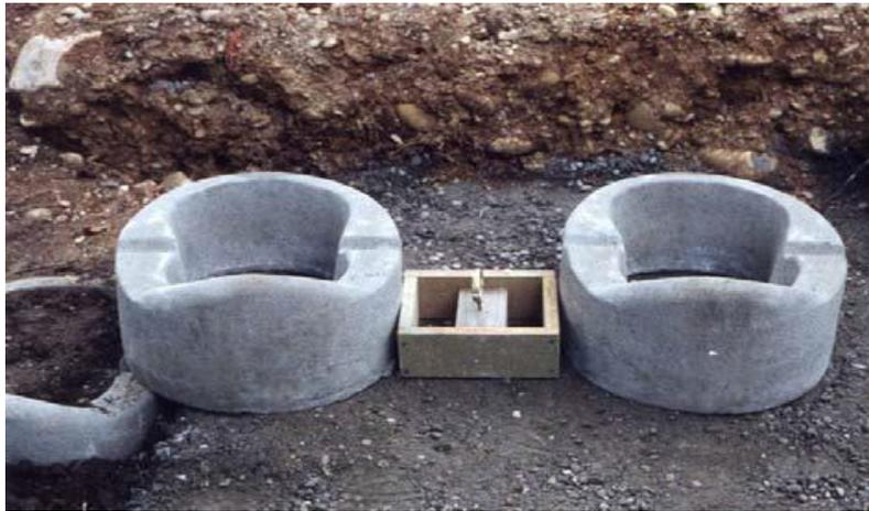
Figure 8.3 : Espacement entre blocs ATALUS
