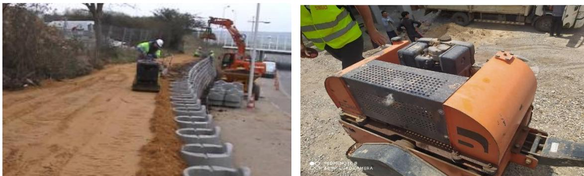
Figure 8.6 : Compactage du remblai par couche
