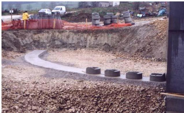
Figure 8.1 : Béton de propreté
