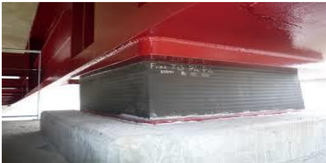
Figure VII-10 : Appareil d'appuis en élastomère frette de type B.
