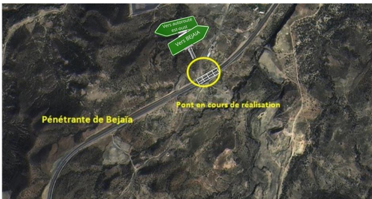
Figure I-1 : Vue satellite du site de l'ouvrage (Google Earth)
