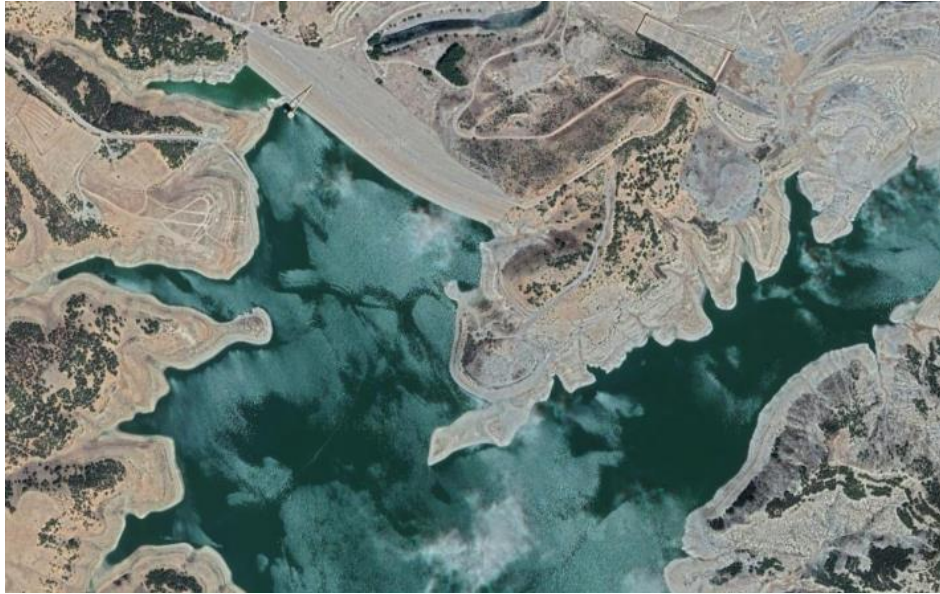
Figure II.2: Barrage d'Ain Zada
