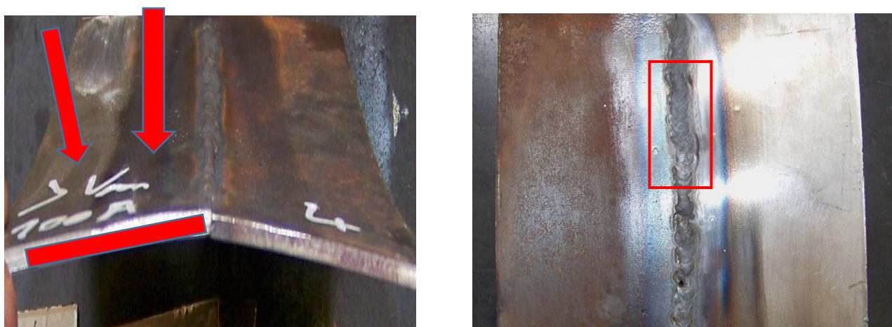
Figure 7-11:inspection visuelle des soudures
