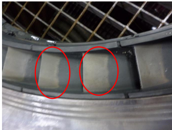
Figure 4-3 Zones de segments présentant un endommagement par usure
