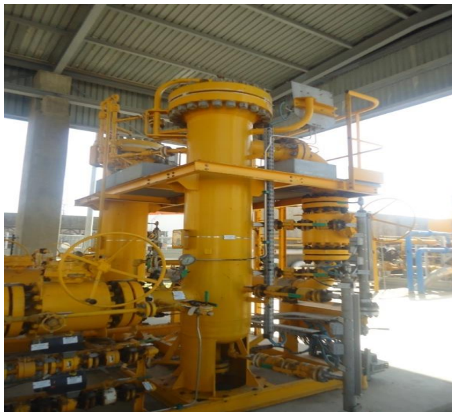
Figure 2.3: Filtre vertical de type à cartouches coalescentes.
