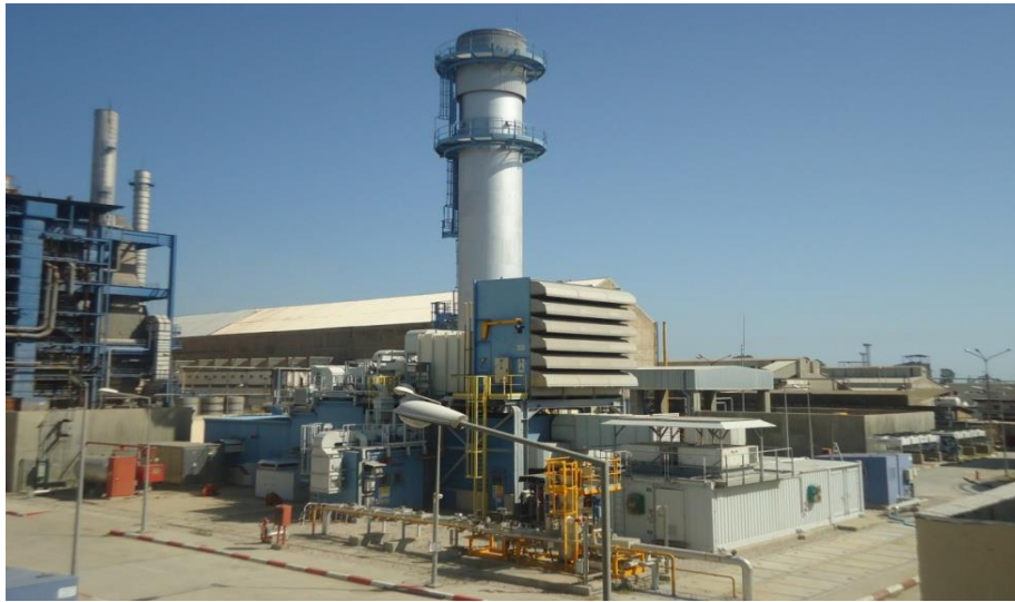
Figure 1.5 : Vue générale de la TG 6000-B
