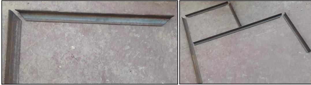
Figure 108- Traçage découpage et soudage le la structure
