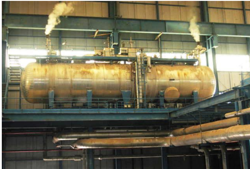
Figure 1. 7: Vue d'une bâche alimentaire de la centrale [ source exclusive]
