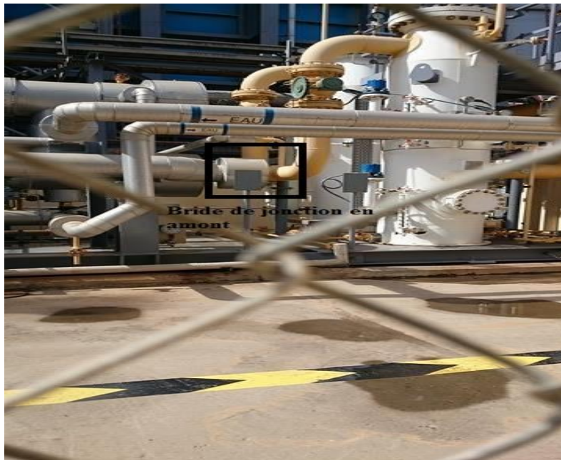
Figure 4-17 : Position de la bride de jonction en amont.
