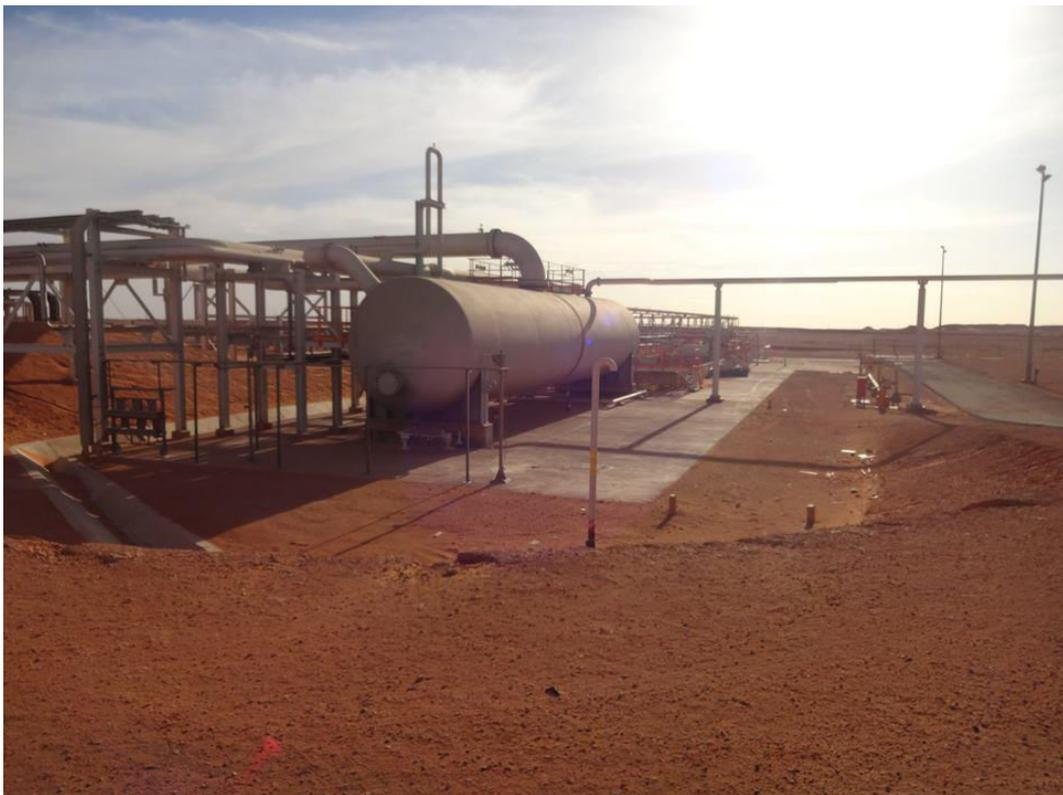
**Figure 7-7: Ballon de séparation Gaz/Liquide du système Torche**
