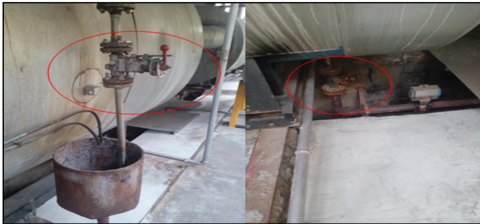
FIGURE 3.21 – Vannes de décantation et de désembuage [Source exclusive]
