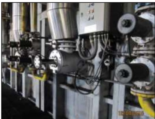
Figure 3-9 : Brûleurs à double flamme (source exclusive)
