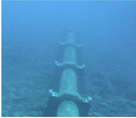
**Figure 1.17.** Conduite d'aspiration de l'eau de mer profonde. ([3])
