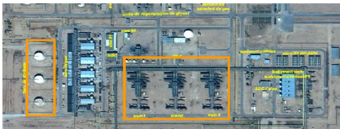
Figure 3-3 : Vue aérienne des installations du Module 1 (MPP1)
