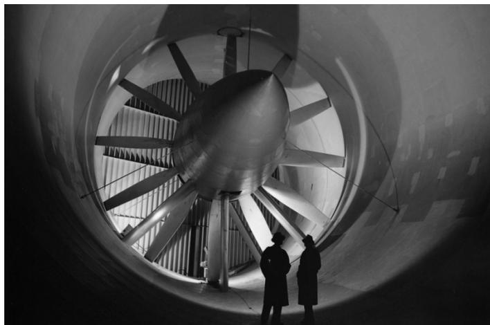
Figure 1-4 Rotor de la soufflerie du centre de recherche Glenn, NASA. Cleveland, OH.
