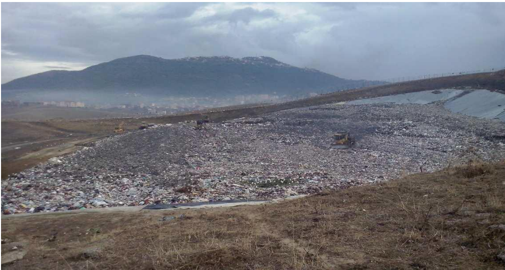
Figure 2.3 : Casier du site d'Oued Falli. Capacité de stockage égale à 360000 m 3 .(EPIC CODEM)
