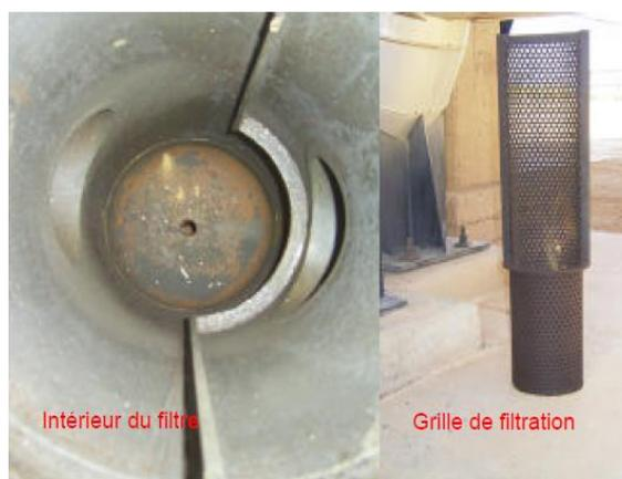
**Figure 2.20** – Vue d'intérieure du filtre à panier
