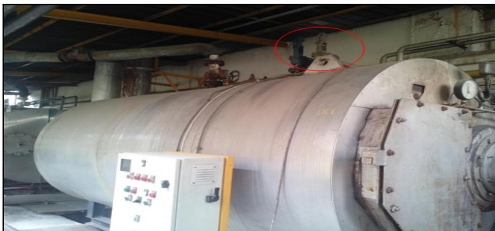
FIGURE 2.11 – Soupapes de la chaudière à vapeur[Source exclusive]
