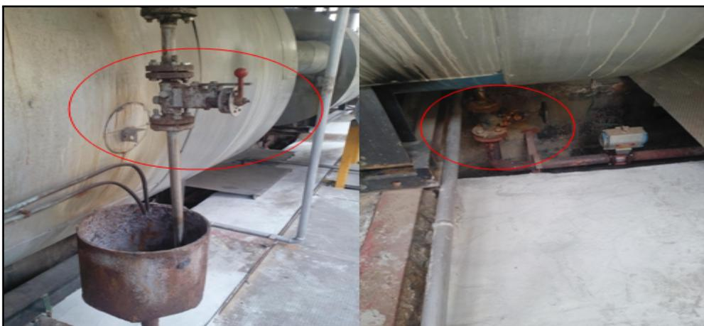
FIGURE 2.13 – Vannes de décantation et de désembuage[Source exclusive]
