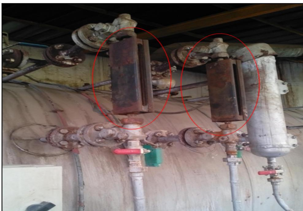
FIGURE 2.16 – Sondes de niveau d'eau [Source exclusive]
