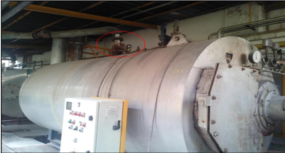
FIGURE 2.12 – Vanne de sureté de la chaudière à vapeur[Source exclusive]
