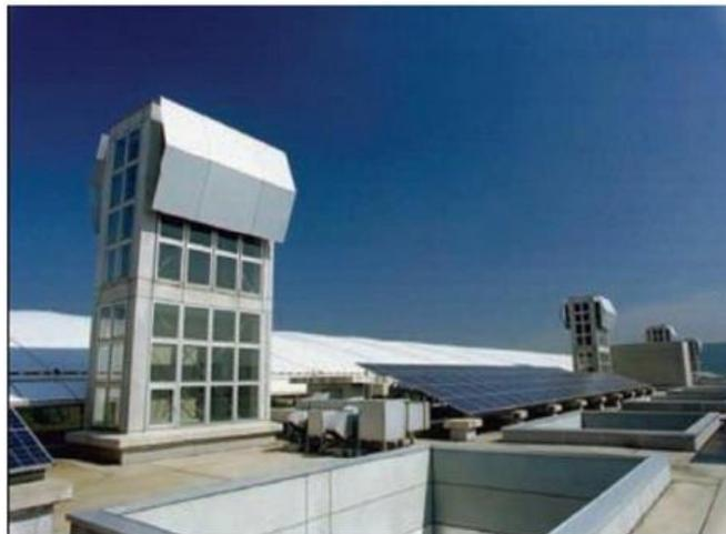
**Figure I.14:** Exemple de cheminée solaire intégrée sur le bâtiment [21].
