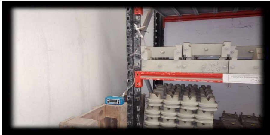
Figure 2-4: Station de prélèvement 2.
