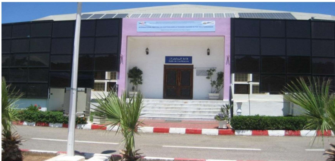
Figure 1-19 Centrale photovoltaïque de 12.5 kWc réalisée à l'UDES
