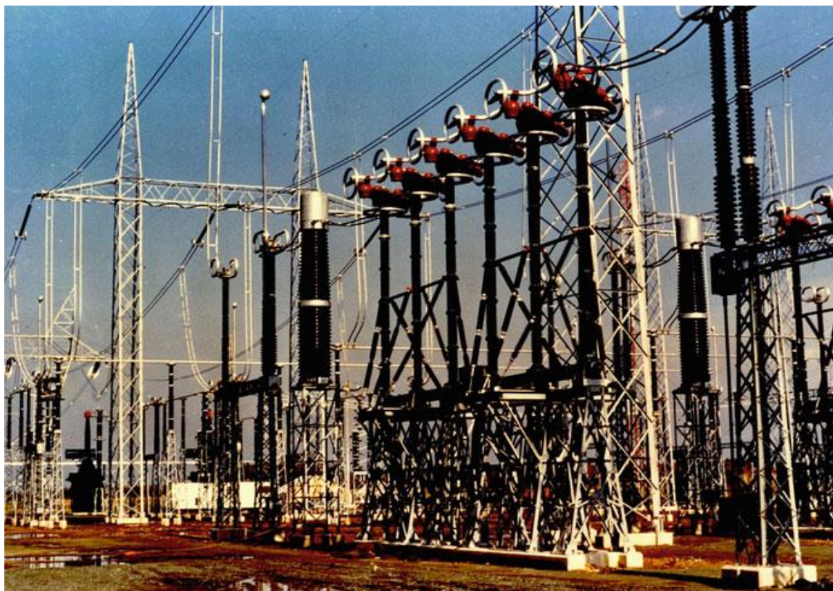
Figure 1.1 : Disjoncteur à air comprimé 800kV [8]
