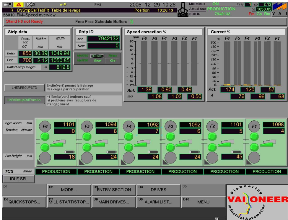
Figure 1.3 Vue du train finisseur et loopers avec l'HMI
