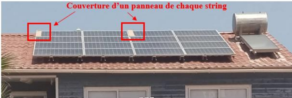
Figure 4.27: Scénario 1 de détection des défauts
