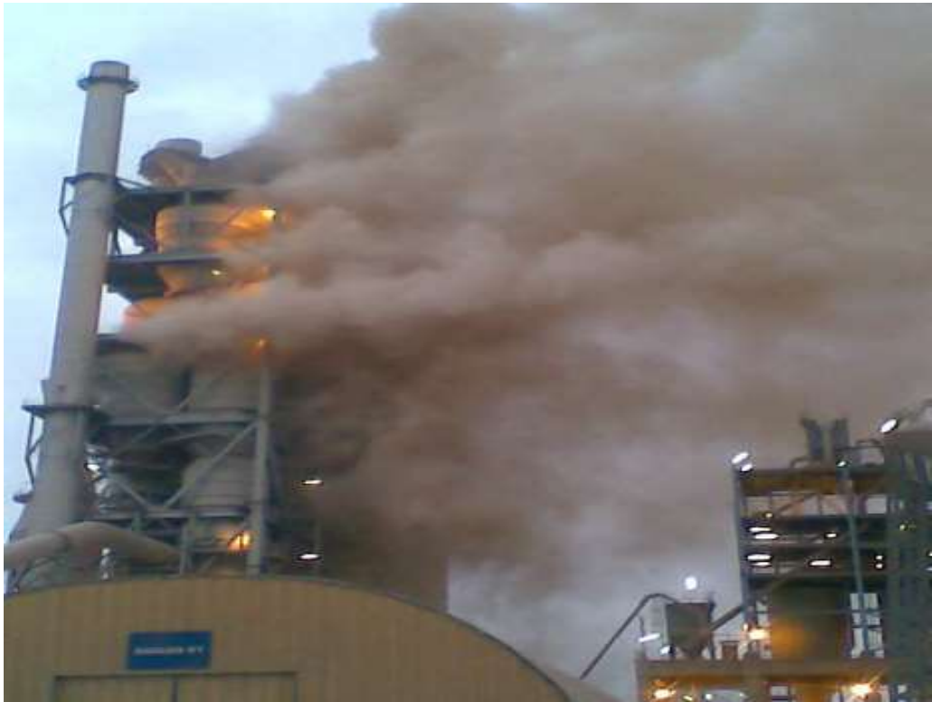
Figure IV- 1 : Conséquence du blocage du cyclone [1]
