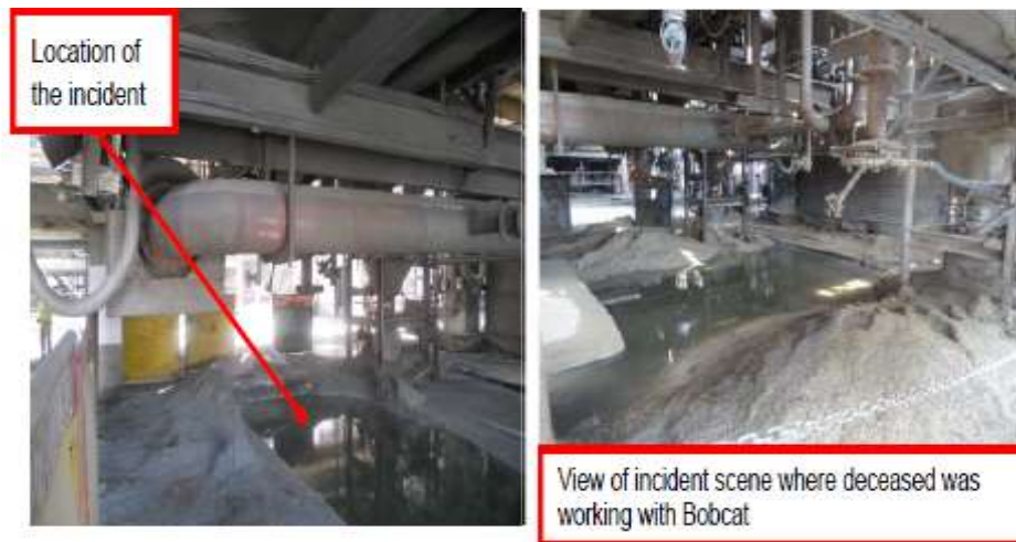
Figure II- 11 : Accident Mortel de la matière chaude du Groupe Ex Holcim Survenue à l'inde [1]
