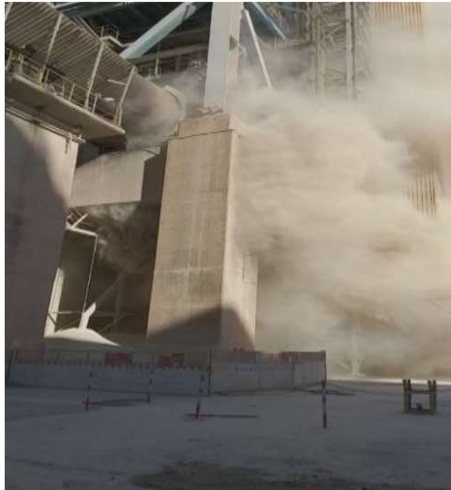
Figure IV- 4 : Fuite de matière chaude au niveau du joint amont à Lafarge Ciment Oggaz
