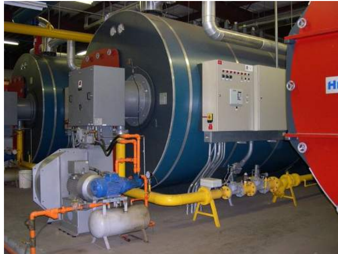
Figure 2.9: Système de chauffage central avec chaudières situées à l'extérieur de la serre.[29]
