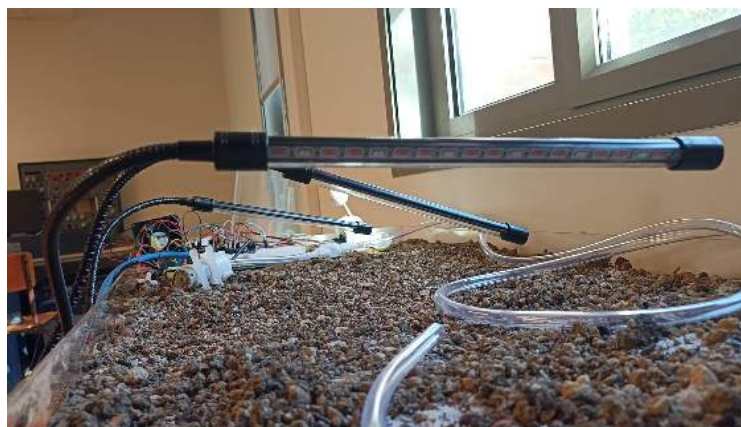
Figure 4.36: Photo du LED mis en place
