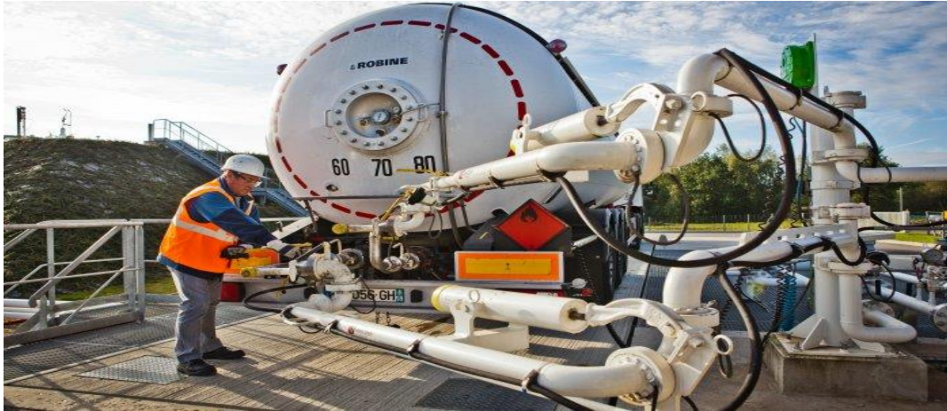
Figure 13: exemple sur l'opération dépotage
