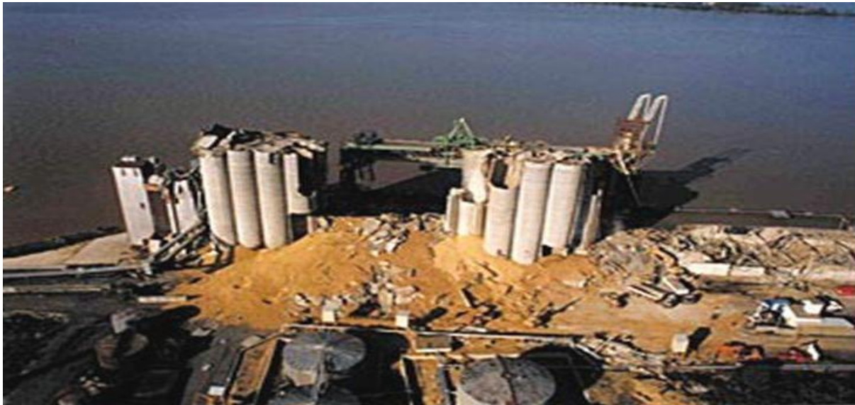
Figure I-6 : Explosion d'un Silo de Céréales à Blaye-Gironde (France) 20 août 1997 (11 morts).
