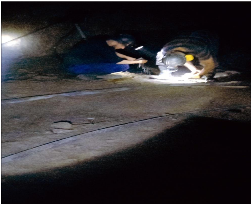
Figure 33 : réparation du tuyau
