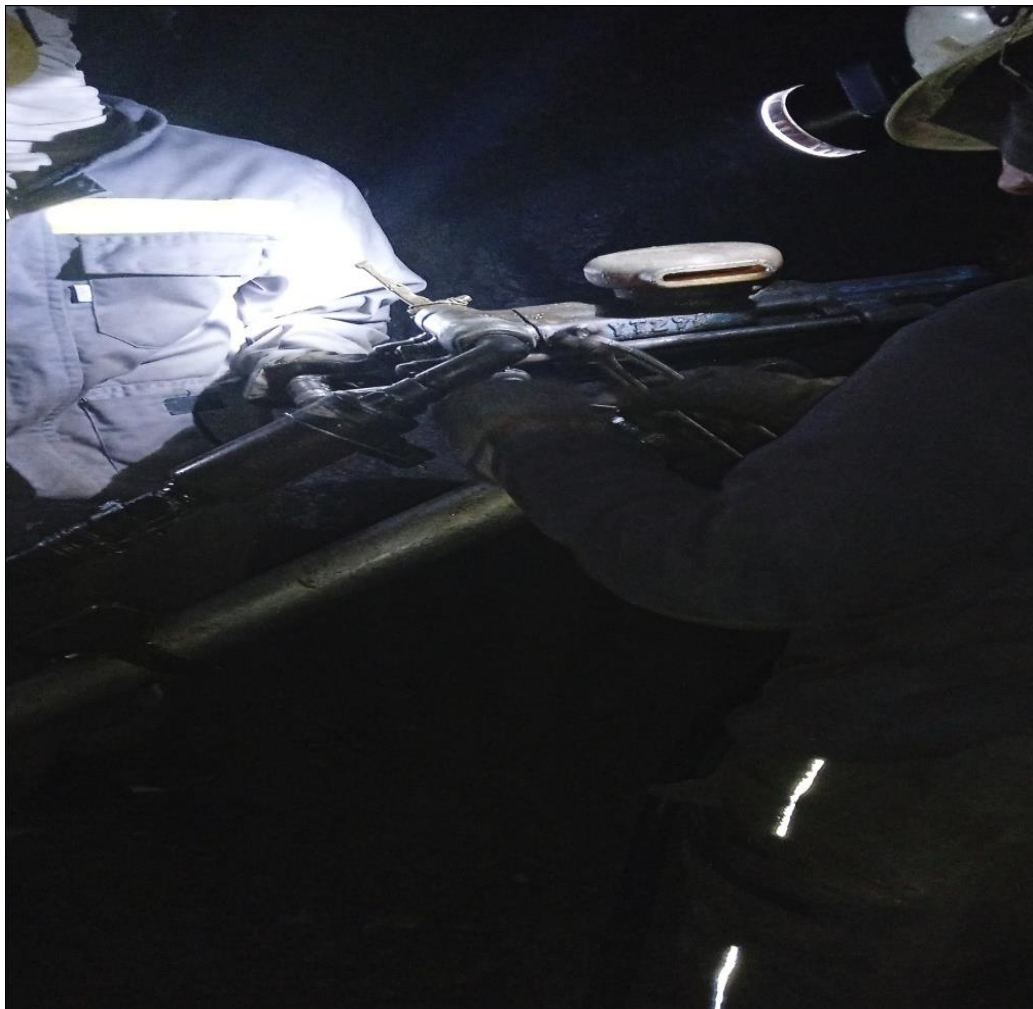
Figure 31 : Réparation de marteau perforateur pendant l'opération de la foration
