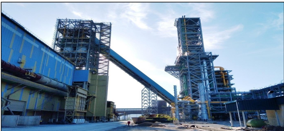
Figure I.13: Transport de pré réduit de minerai de fer (DRI) vers lacerie électrique.
