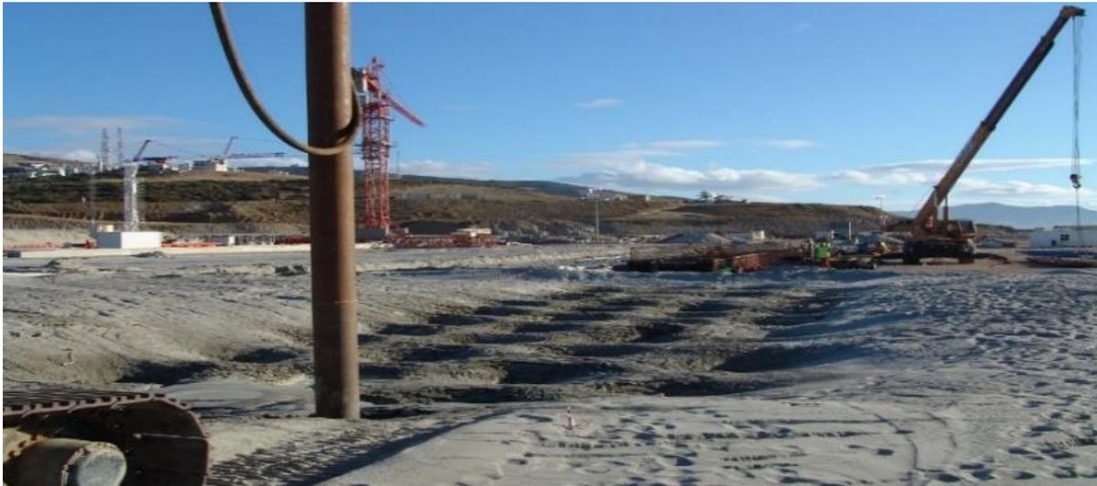
*Figure 2-8 : Amélioration des sols par vibro-compaction*
