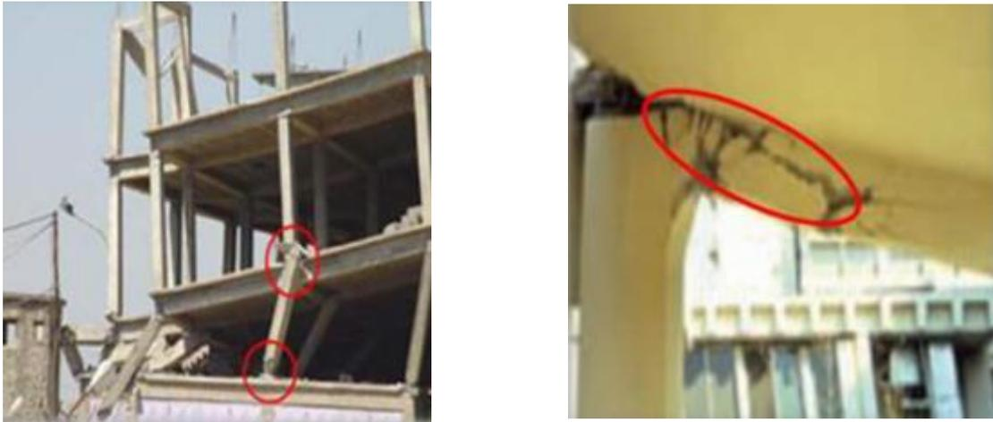
**Figure IV-2 : Rotule plastique au niveau des poutres et des poteaux.**
