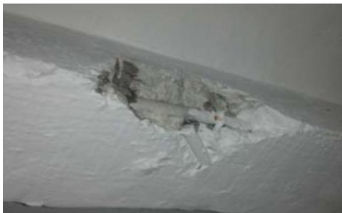
**Figure II-8 : éclatement du béton et apparition des aciers.**
