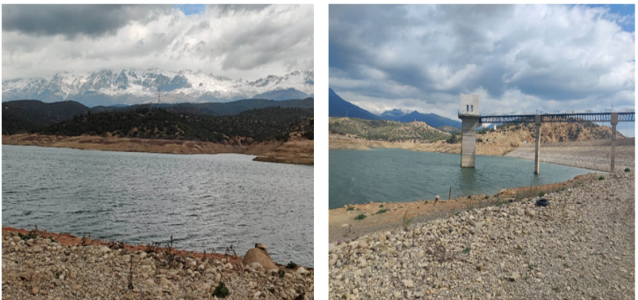
FIGURE II.14 – Vue général du barrage de Tilesdit (2023)
