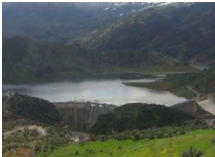
FIGURE II.15 – Barrage de Lekhal destiné à l'irrigation [3]
