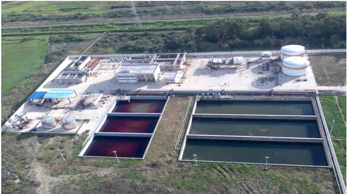
Figure 1. 3 : Vue générale de l'Unité de Traitement des Effluents
