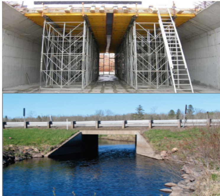
FIGURE IV.8 – Dalot ordinaire avec dalle [25]
