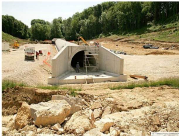
FIGURE IV.12 – Aménagements de protection de l'ouvrage de franchissement[25]
