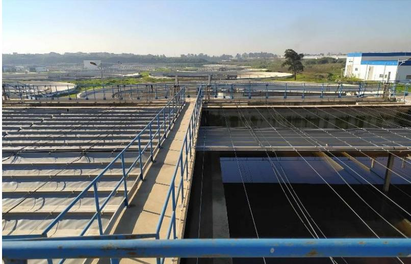
**Figure III.1** : Les filtres à sable de la STEP de Baraki
