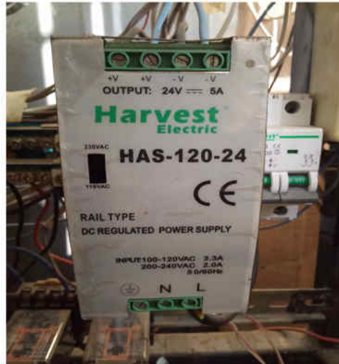
Figure B.4.1 : Alimentation Redressé Stablié HAS-120-24
