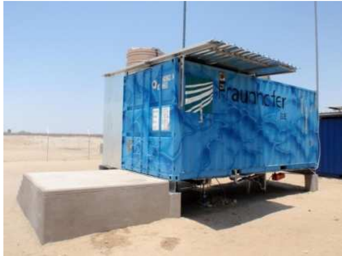
Fig. 2.16 Usine de distillation membranaire, installée à l'intérieur d'un conteneur (Namibie)
