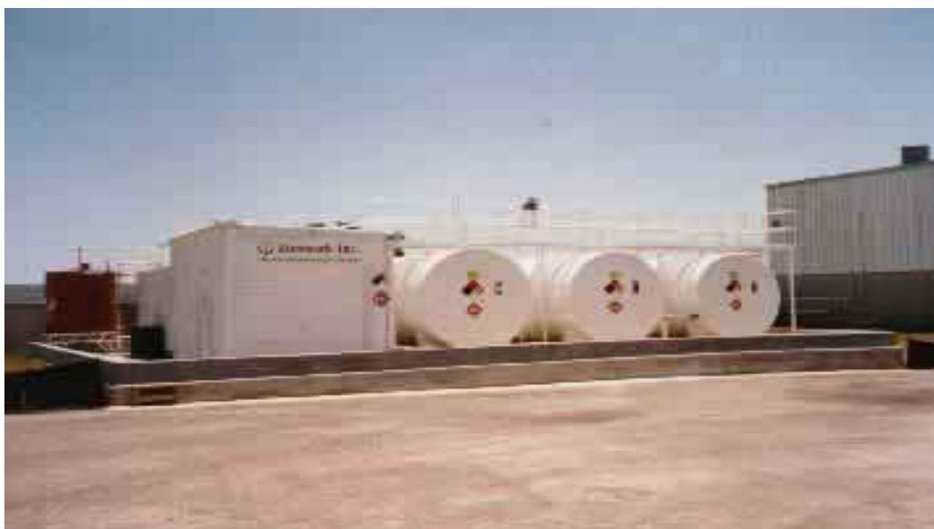
Figure8 : Conteneurs-citernes d'huile lubrifiante sur le site de récupération.
