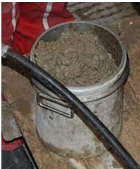
Figure 48 : Récipient cylindrique rempli du béton
