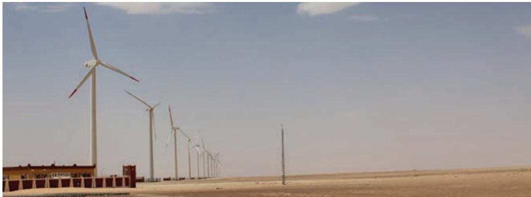
Figure 1.3 – Ferme éolienne de 10 MW du site Kaberten-Adrar (2014) [23].
