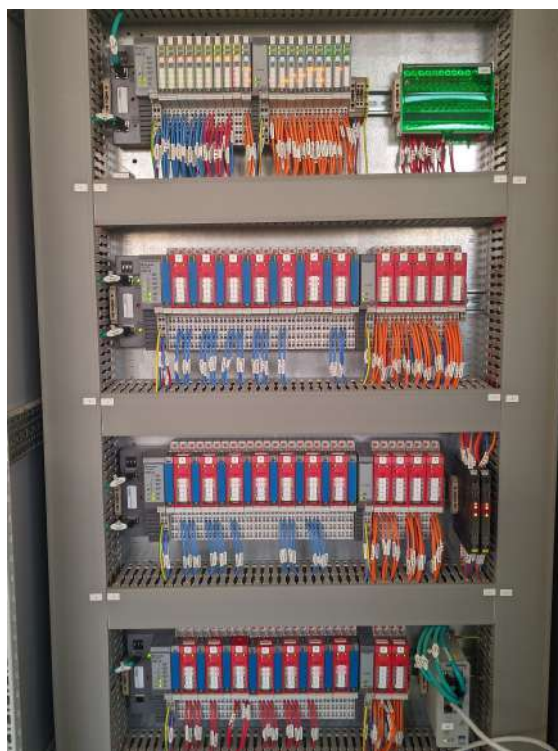
FIGURE 2.17 – Les quatre châssis connectés en série
