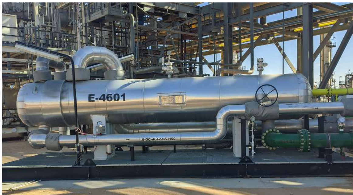
FIGURE 2.9 – Échangeur de chaleur E-4601
