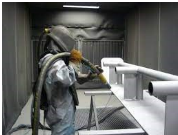
Figure II.5: Nettoyage par grenailage [46]
