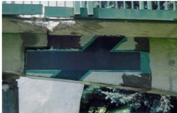
FIGURE 2.11 – Application de la méthode de collage extérieur pour la réparation d'un pont [55].
