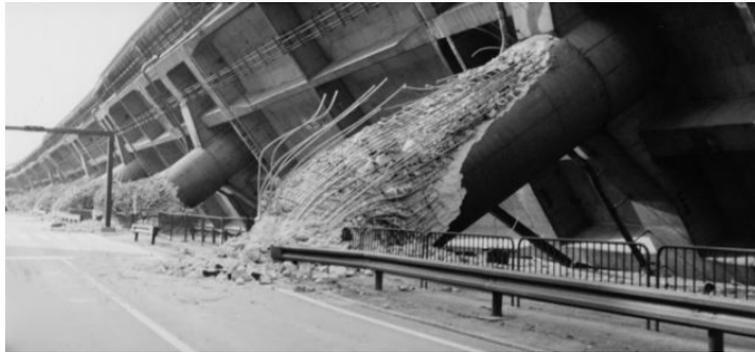
FIGURE 1.3 – Rupture en flexion à la base de la pile de pont du Hanshin Expressway lors du tremblement de terre de Kobe en 1995 [11].
