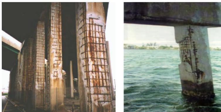
FIGURE 1.2 – Colonnes de pont endommagées par la corrosion de l'acier de renforcement en raison d'un environnement sévère [7].
