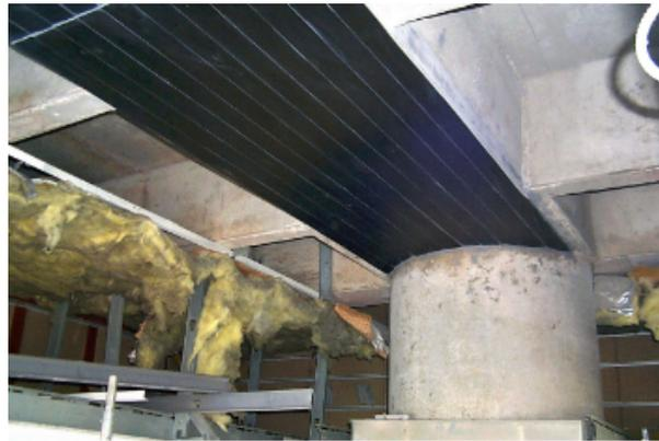
FIGURE 2.14 – lamelles de carbone appliquées pour renforcement
