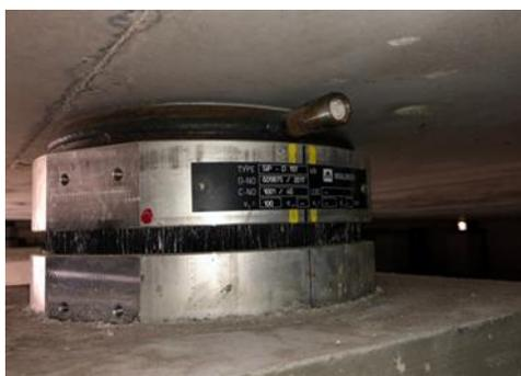
Figure II. 11 : Appareils d'appuis
