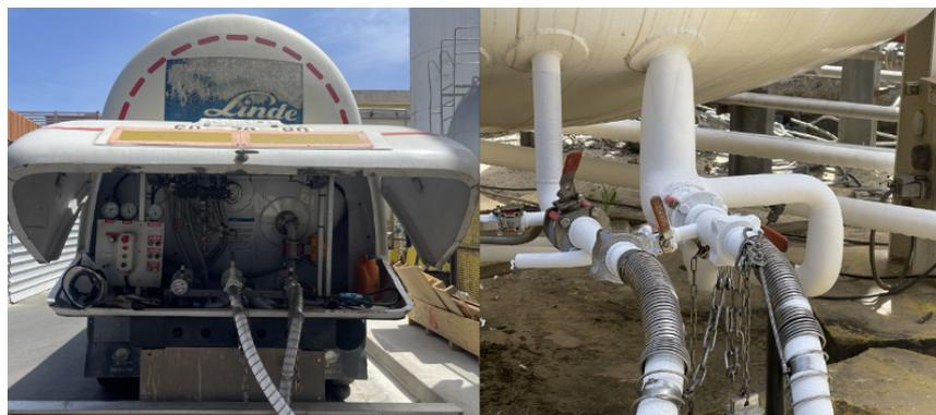
FIG. 1.1 : Canalisation entre citerne du Linde Gas et le réservoir de la station du stockage du CO<sub>2</sub>
