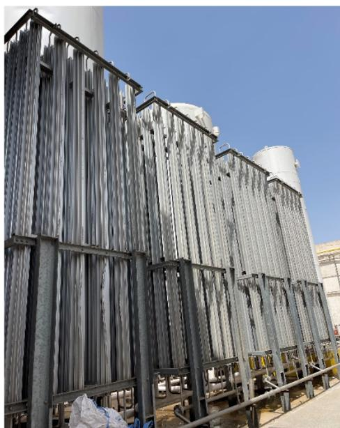
FIG. 3.3 : Photo réelle des 04 vaporisateurs en série
